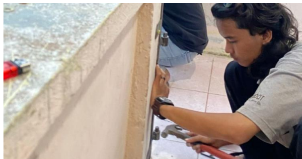
Gambar 13. Pemasangan pintu terali di pojok baca.
