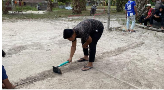
Gambar 21. Perbaikan fasilitas umum di lapangan.
