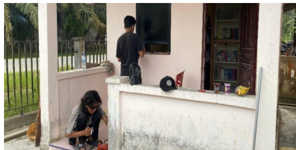
Gambar 11. Pemasangan jendela tambahan pada pojok baca/perpustakaan kantor desa.
